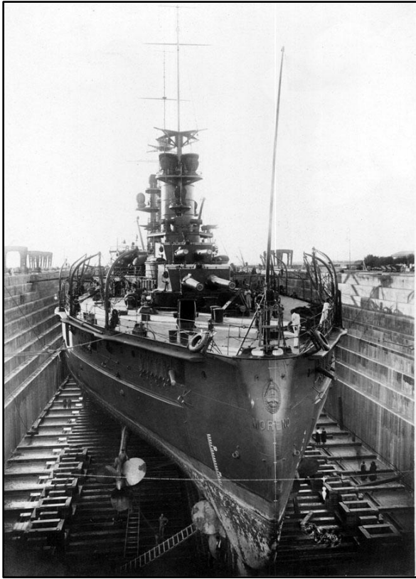
Uno de los acorazados en fase final de la construcción
