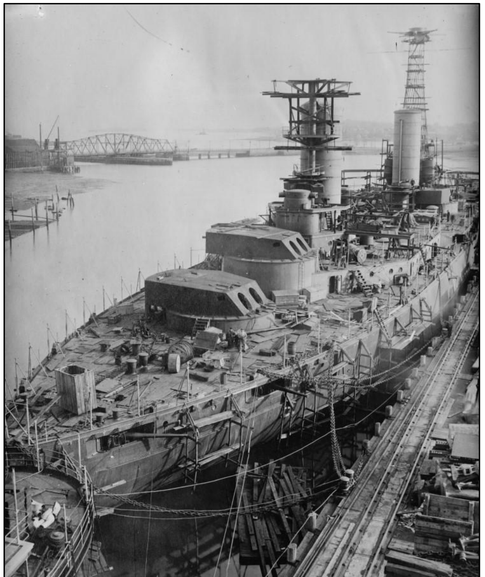
En construcción en el astillero de Nueva Jersey
