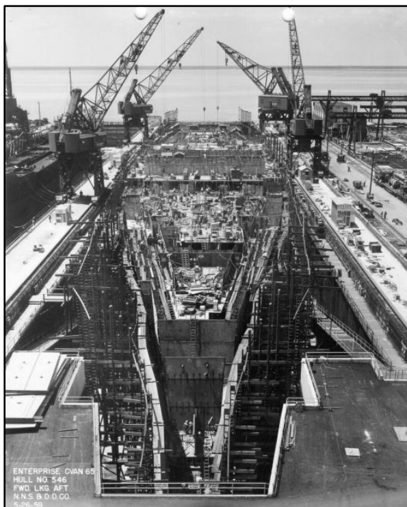
El casco del Enterprise durante la construcción. Nótese que fue construido por secciones en diques distintos
